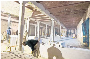
Derzeit entsteht im Inneren des Gebäudes eine Brandschutzmauer, die das Haus in zwei Teile trennt: Weinlager und Bürotrakt.
